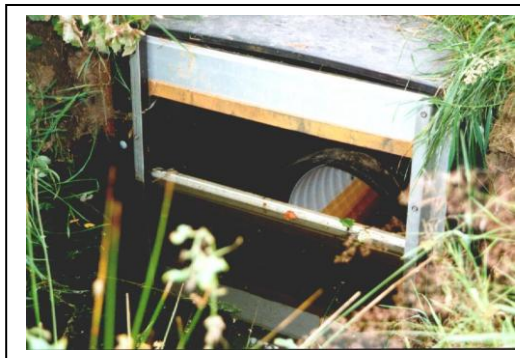
Kleine dammetjes houden het water tegen en laten het bezinken
