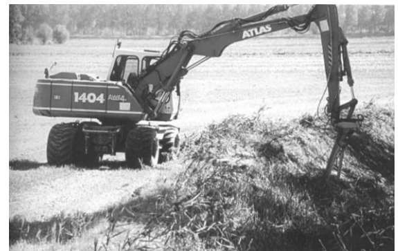
Zonder het recht op doorgang kunnen de noodzakelijke ruimingswerken niet gebeuren.
