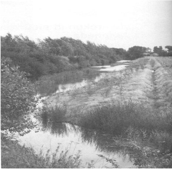
Een mooi voorbeeld van integraal waterbeheer in de Zwarte Sluispolder: een waterloop ingericht met oeverstroken, zwakke hellingen en een langsracht voor de afwatering van de landbouwgronden.
