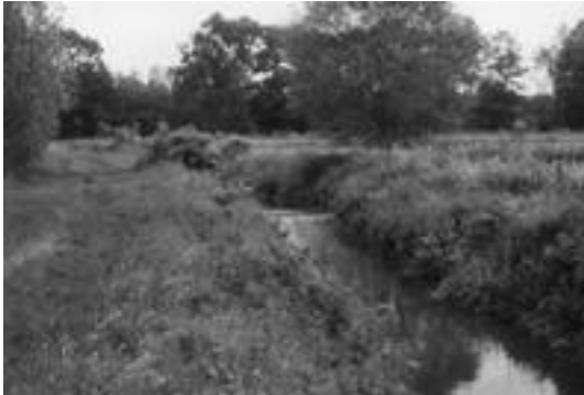
Een kleine bodemval die verdere uitschuring moet voorkomen
